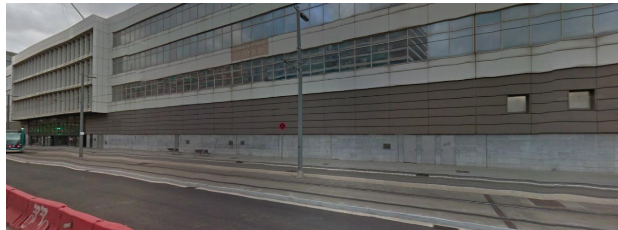
Dos situacions antagòniques: A dalt, fotografia de la permeabilitat de la façana de la Diagonal amb comerços accessibles des del carrer, i a baix, fotografia de la façana cega de la Gran Via.
