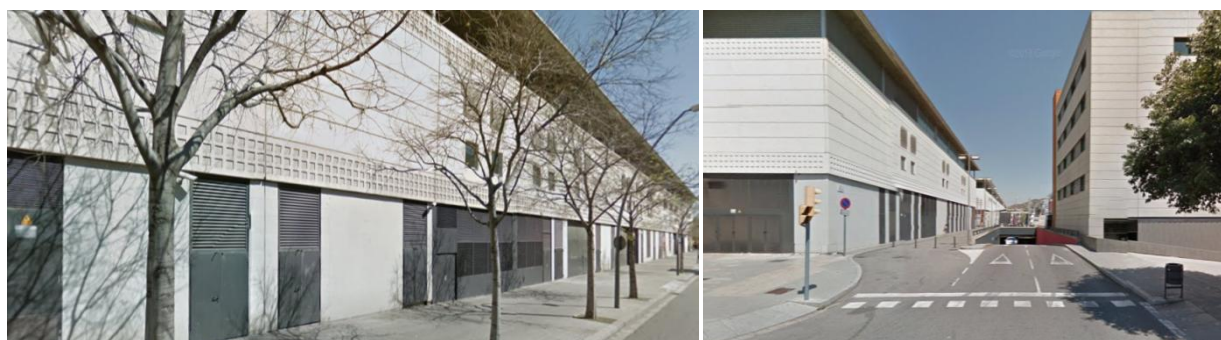
Façana del carrer Sao Paulo, i façana posterior, en contacte amb els concessionaris de vehicles.
