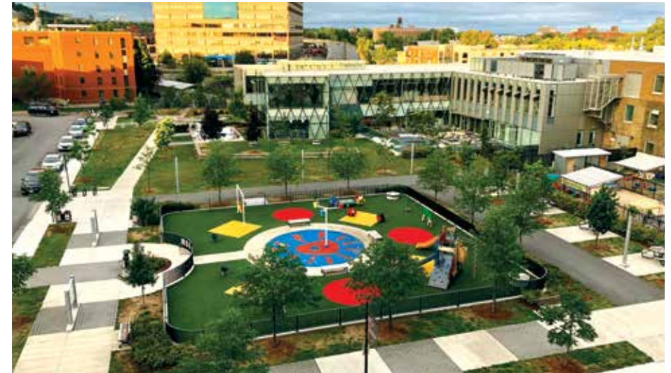
Obras en los antiguos terrenos de Rosemont, el primer proyecto inclusivo construido en suelo municipal. Nueva trama urbana, muchas iniciativas ecológicas (instalación geotérmica, persianas eficientes, etc.), parada de metro, biblioteca, guardería y tiendas.
