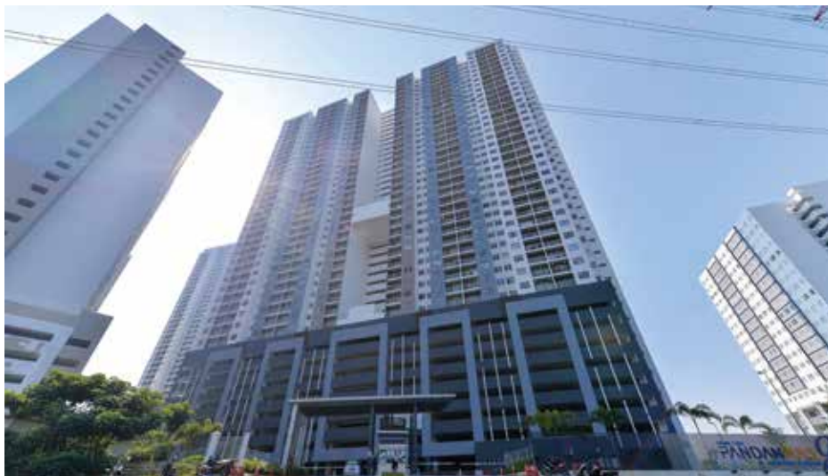
Uno de los edificios terminados es Residensi Pandamas 2, formado por 1.920 unidades del programa de vivienda asequible (RUMAWIP).
