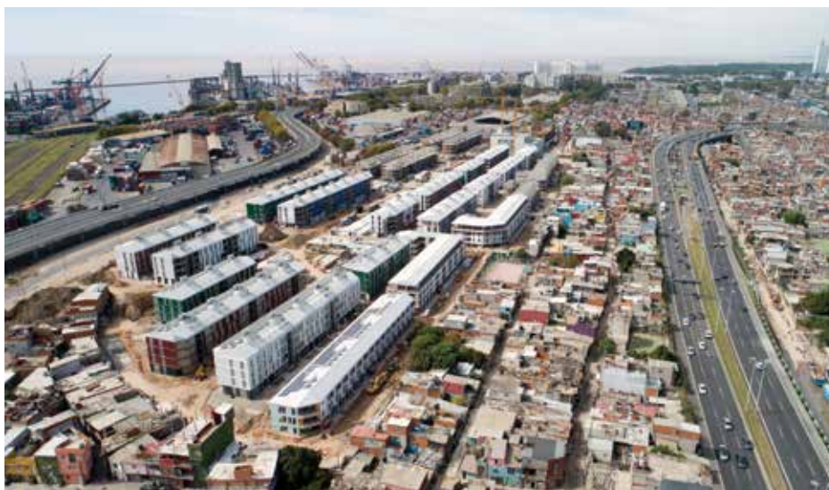
Nuevas viviendas que se están construyendo en el Barrio 31.
