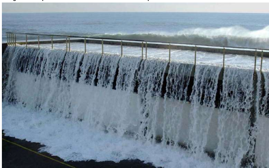
Imatge 35: Ultrapassament del dic de recer durant un temporal de llevant
