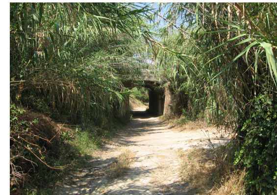
d Pont del torrent de Can Milano (Font JM)
