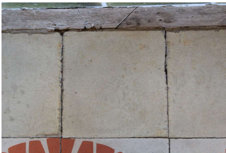
El terra del menjador és l'únic de tot l'edifici que conserva el seu acabat original. Es tracta d'un mosaic de ciment hidràulic de la fàbrica Orsolà i Solà.
