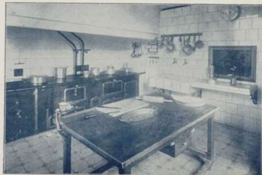
Vista parcial de la Cocina
