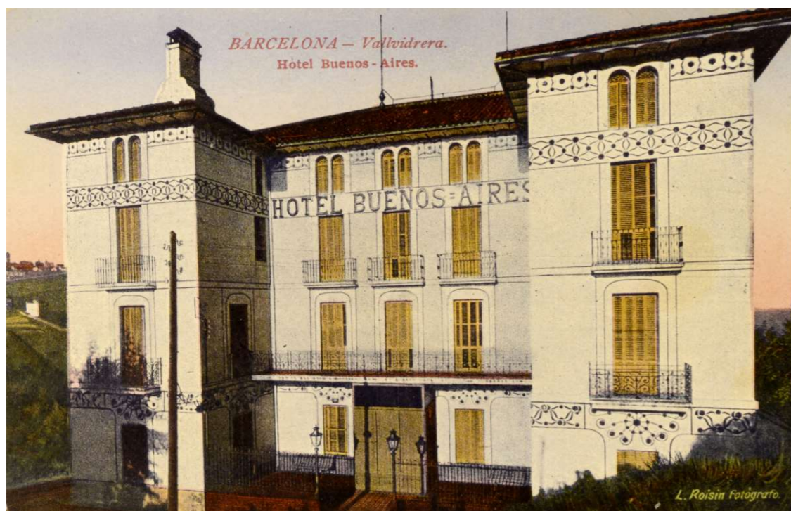
Façana oest de l'Hotel Buenos Aires després de la reforma de Jeroni Granell, segons foto de Roisin c.1915 (Font: AMDSG)
