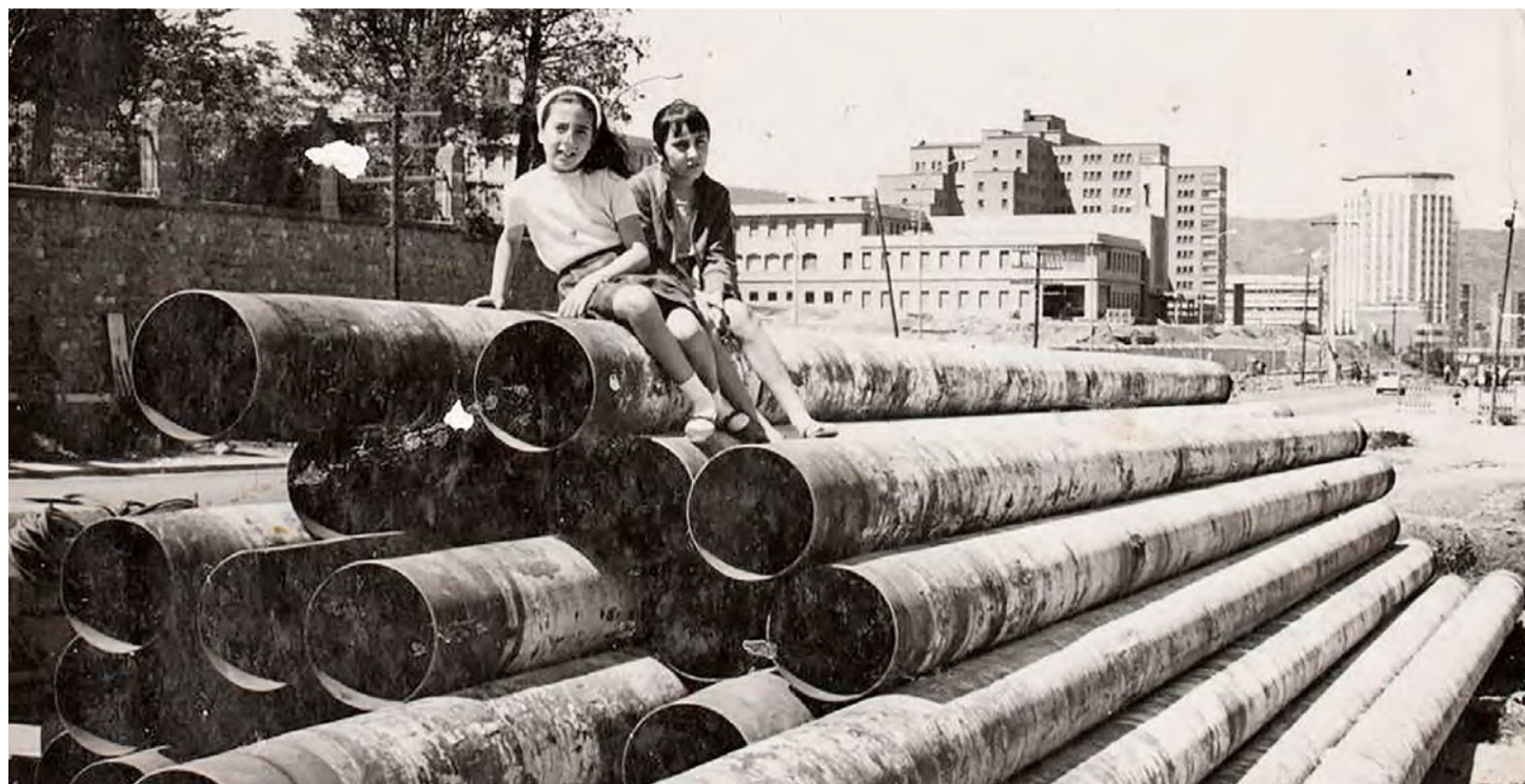
Loli i Isabel Notó al passeig de la Vall d'Hebron. Darrere d'elles i d'esquerra a dreta, el mur de la finca del Patronat Ribas, l'edifici de l'Hospital de Sant Rafael, la residència de la Vall d'Hebron i l'Hospital Maternoinfantil, que va ser inaugurat el 1967. Autor: José M. Notó. Data: 1965. Cedent: Isabel Notó Igual. Arxiu: Fons Isabel Notó.
