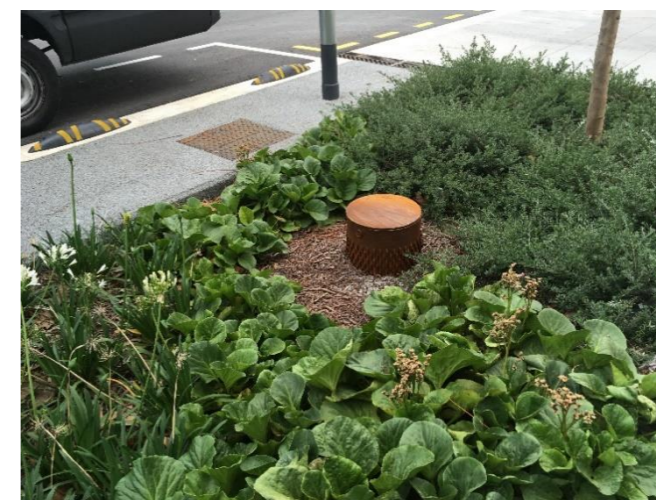
Accés registrable a I-DIP 09 (baix la franja de biorretenció T-BIO 02)
