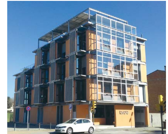
MANLLEU. BARCELONA. Vista de la instalación solar fotovoltaica en el piloto del ecoedificio y sede de Lavola, uno de los socios del proyecto. Fotografía: BCNecologia
