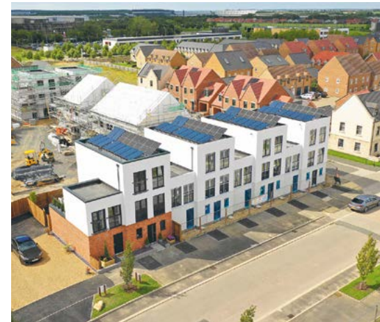
CORBY. REINO UNIDO. 2020. Vista aérea de las cuatro primeras viviendas del piloto del proyecto Chess Setup, ejecutado por Electric Corby. Fotografía: Electric Corby
