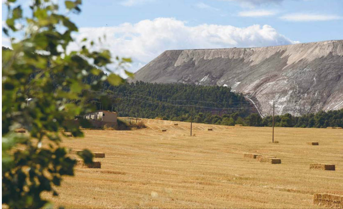
SALIENT DESDE EL LLOBREGAT. Escombrera del Cogulló. Una de las escombreras salinas del Bages que puede incidir negativamente en la calidad del agua del río Llobregat. Fotografía: Archivo Salvador Redó. Regió7. 28 de enero de 2018.
