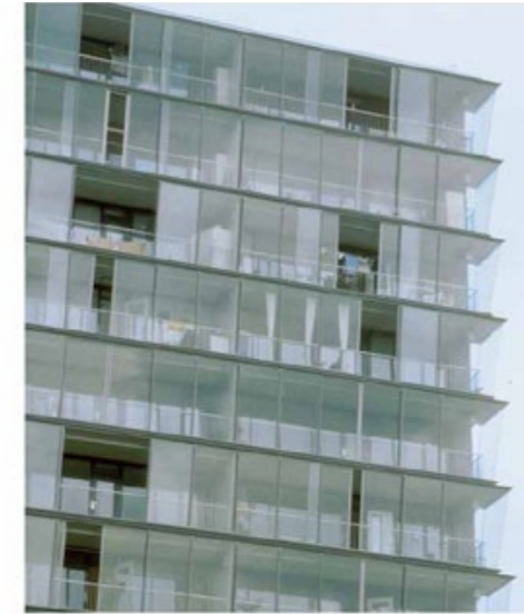
Sterregevel met schuifende duren | Sliding poach facade with sliding doors
