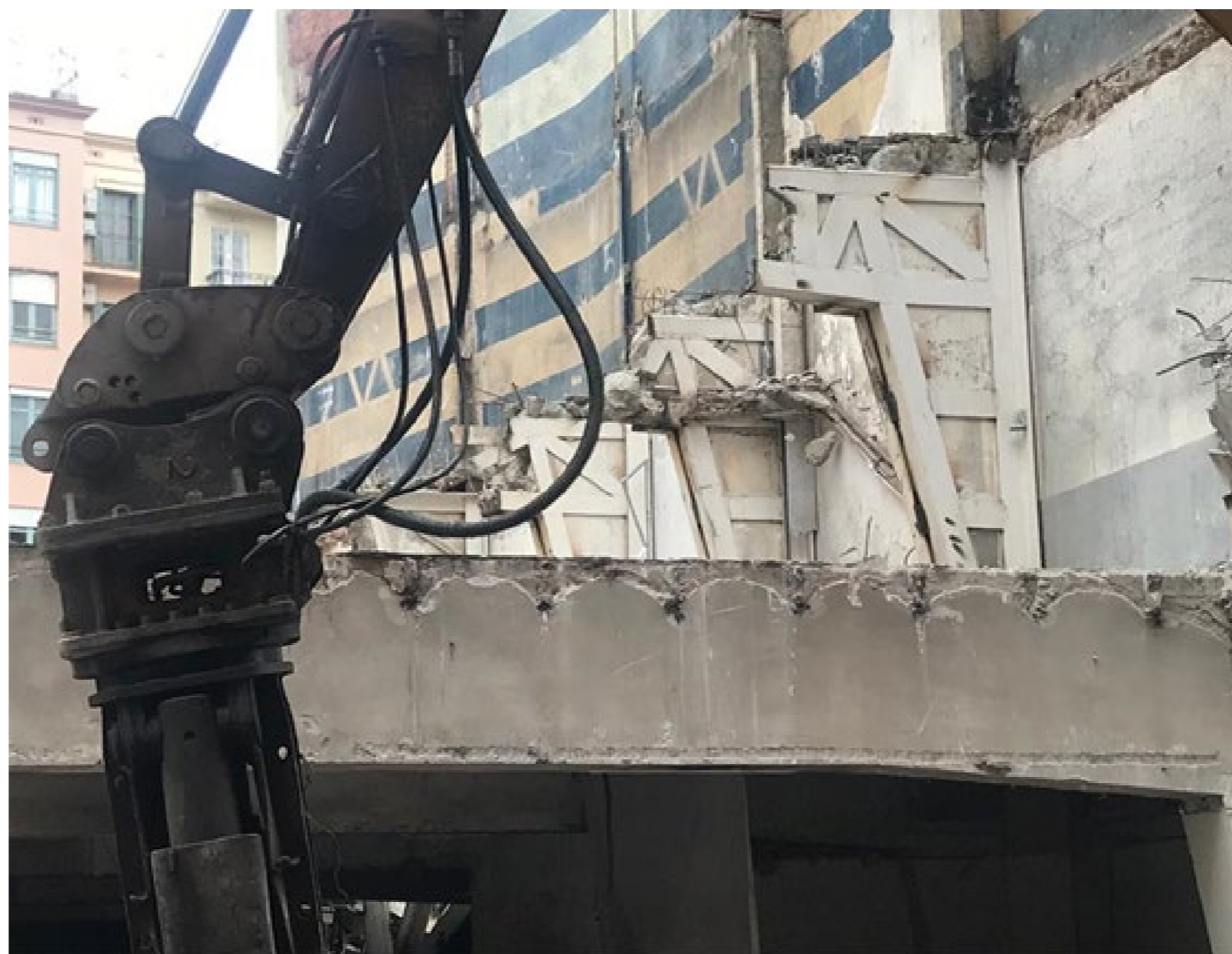
Enderroc amb maquinària pesada d'una estructura robusta enmig del teixit urbà de la ciutat
