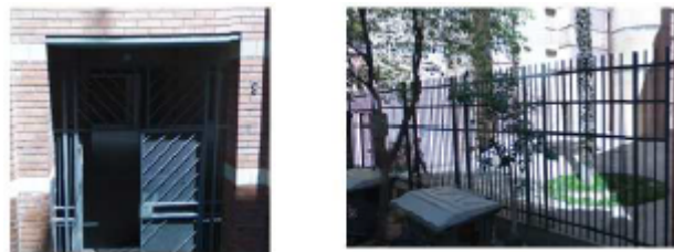
Imagen 40: Entradas al edificio de la calle Om.
