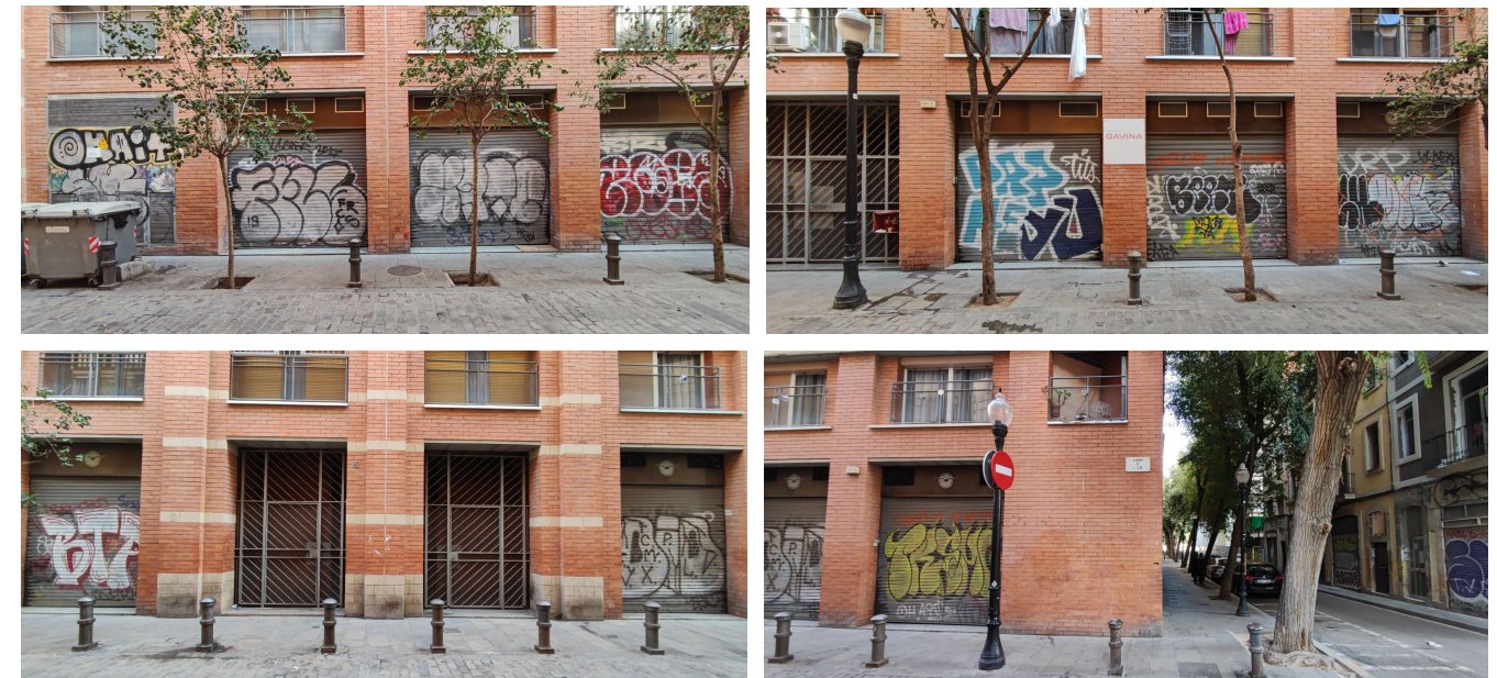
Locals del carrer Om en la façana nord.
