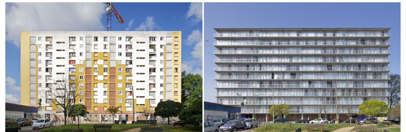
Transformació de 530 habitatges. Abans - després. Edificis G, H, I, barri del Gran Parc. Lacaton et Vassal, arquitectes. Fotografia de Philippe Ruault.
