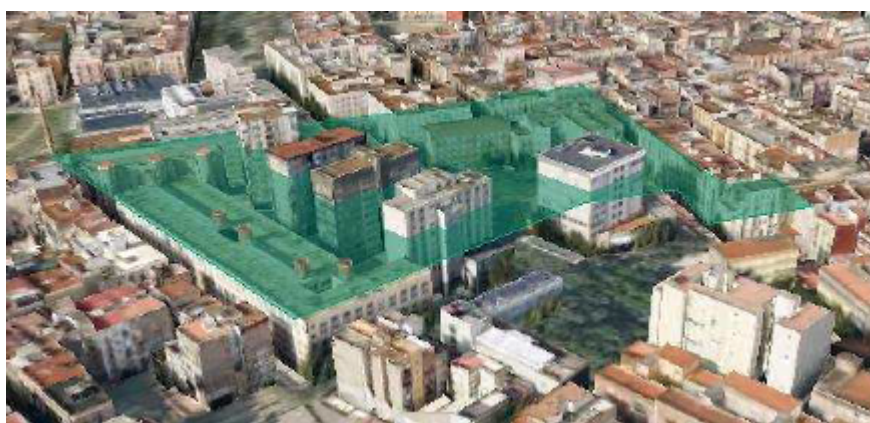
Imagen 42: Vista actual del área a rehabilitar.
