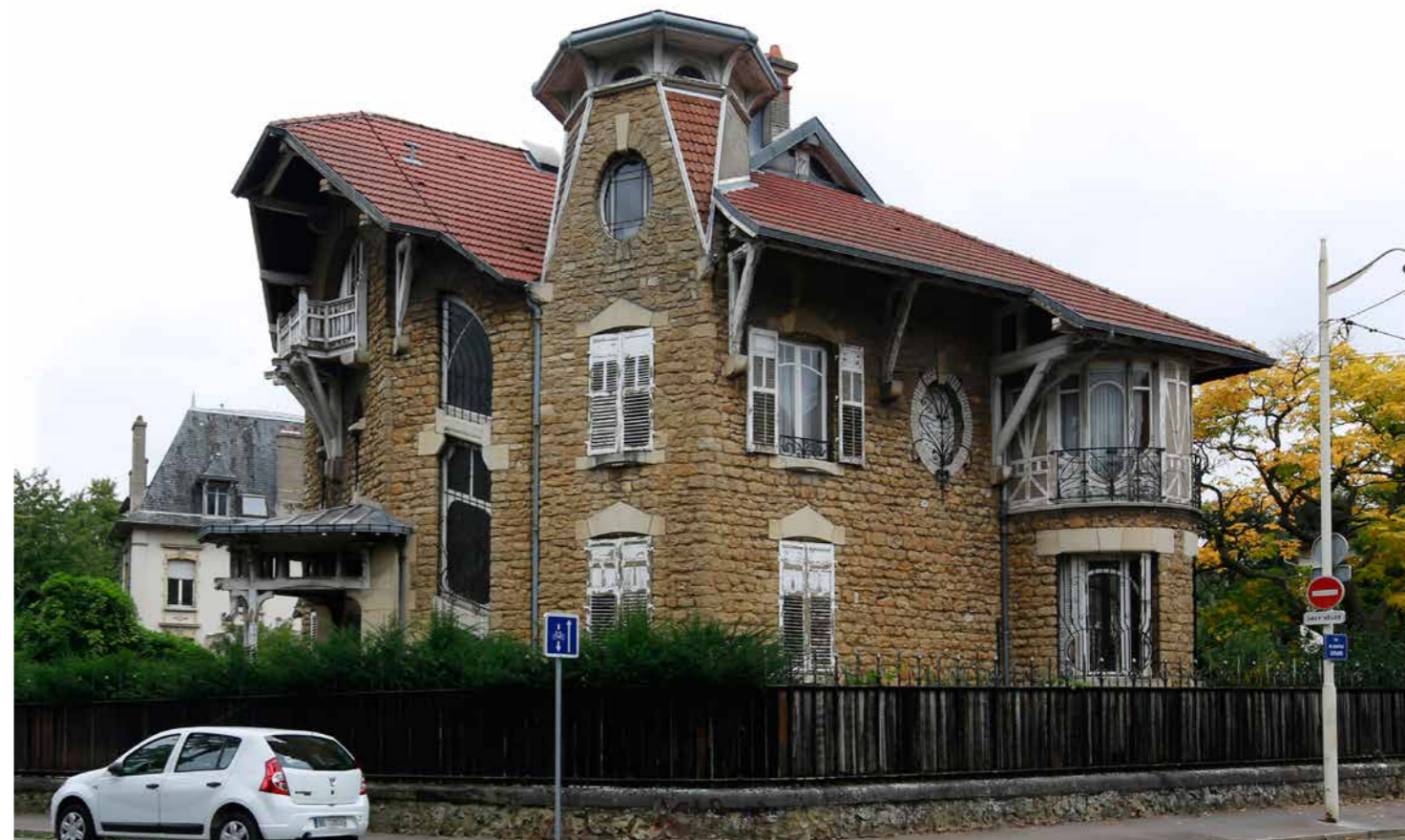
Villa Marguerite, another house in Parc Saurupt, built by Henri Gutton and Joseph Hornecker in 1904 Vil·la Marguerite, una altra casa al parc Saurupt, construïda el 1904 per Henri Gutton i Joseph Hornecker
