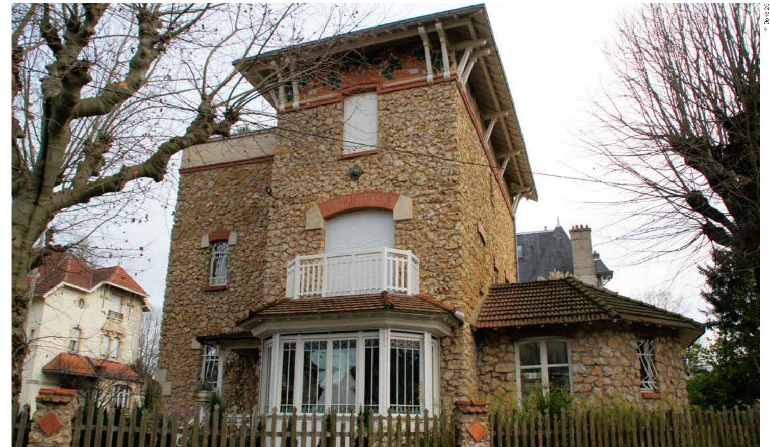
Villa Les Roches, one of Émile André's houses built on the Parc Saurupt development La Vil·la Les Roches, una de les cases construïdes per Émile André a la promoció immobiliària del parc Saurupt
