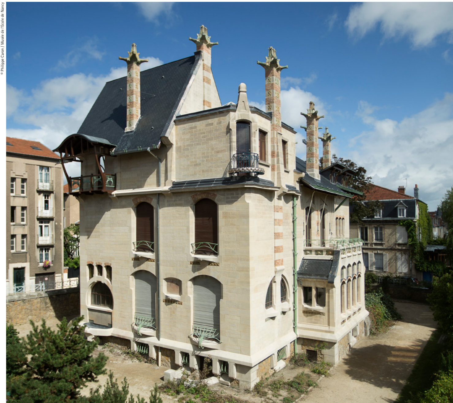
View of the villa after the 2017 façade restoration. In the process, it was decided to preserve the bay window which had been added to the ground floor terrace in 1931 Vista de la vil·la després de la restauració de la façana de 2017. Es va decidir conservar el mirador de la terrassa de la planta baixa, que havia estat afegit l'any 1931
