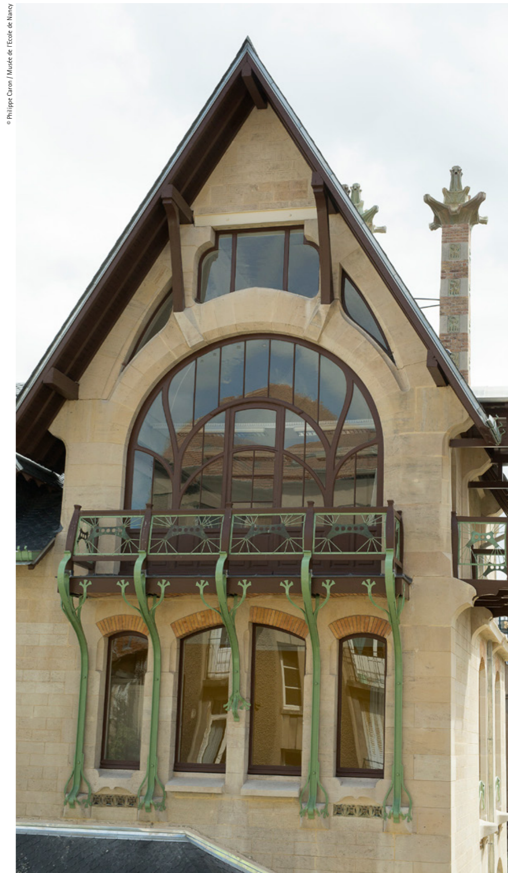
Detail of the façade after the 2017 restoration Detall de la façana després de la restauració realitzada el 2017
