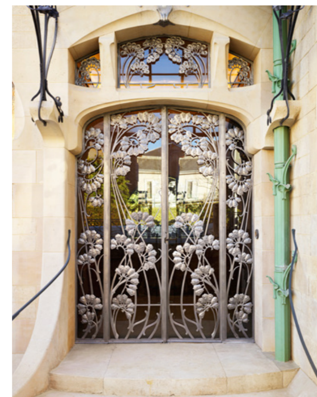
The villa's main entrance after restoration Porta principal d'accés a la vil·la després de la restauració
