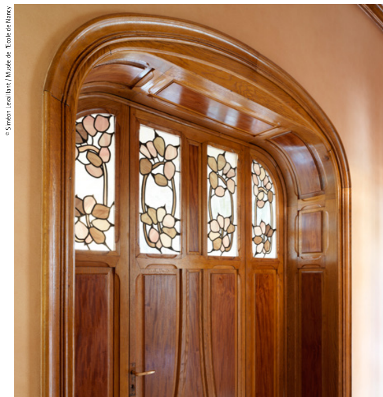
Detail of one of the villa's entrance doors. The stained glass has been completely restored Detall d'una de les portes d'accés a la vil·la. El vitrall ha estat totalment restaurat
