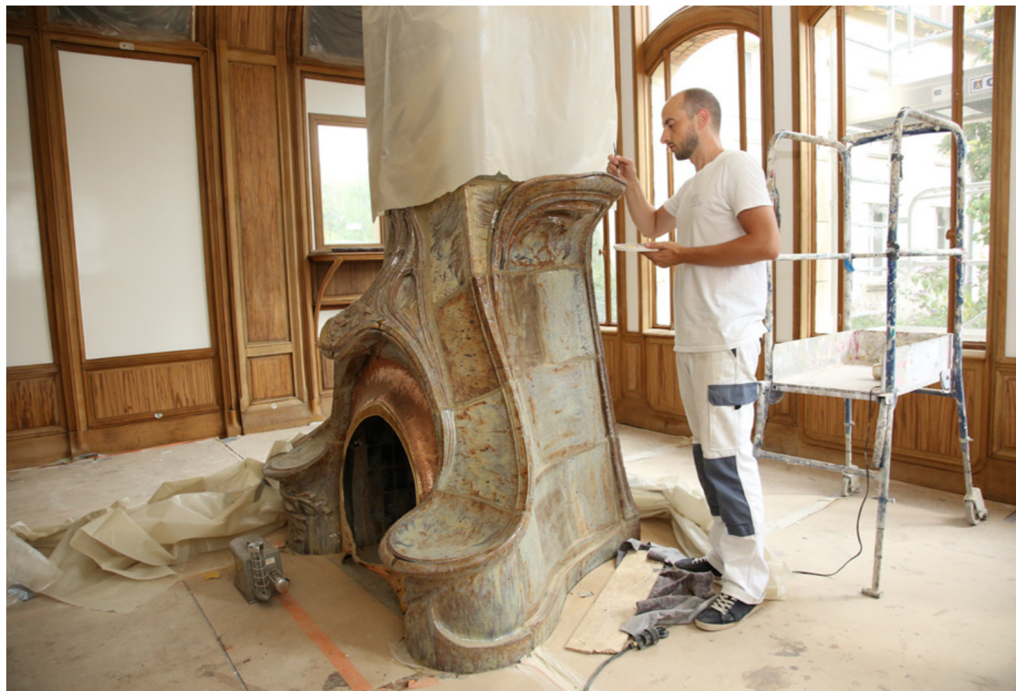
Restoration process of the flambé sandstone fireplace in the dining room, a work by Alexandre Bigot Procés de restauració de la llar de foc de gres flamejat del menjador, dissenyada per Alexandre Bigot
