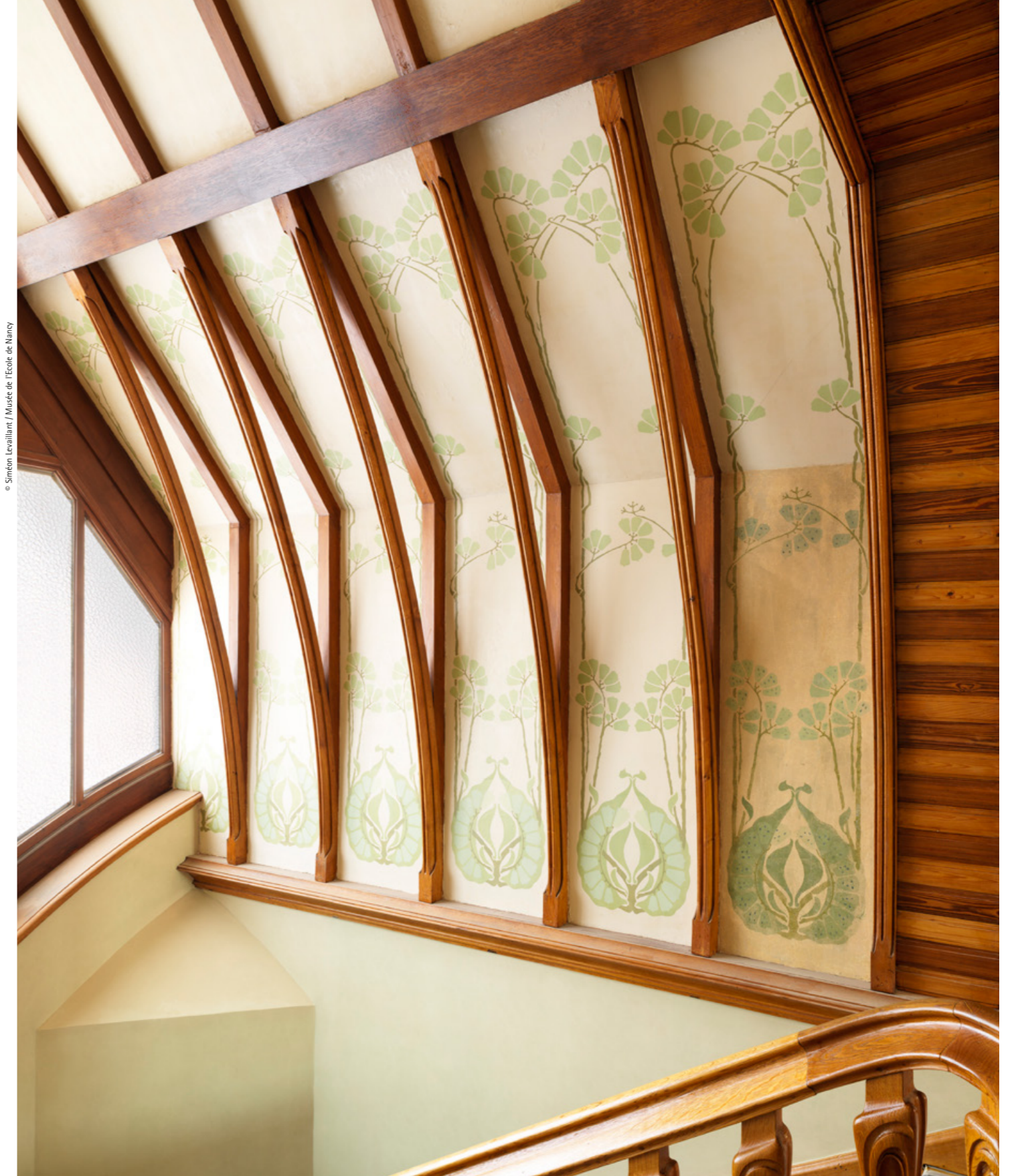
Stairwell detail showing the ornamental stucco and ceiling cladding after restoration Detall del buc de l'escala on s'aprecien els estucs ornamentals i el revestiment mural del sostre després de la restauració
