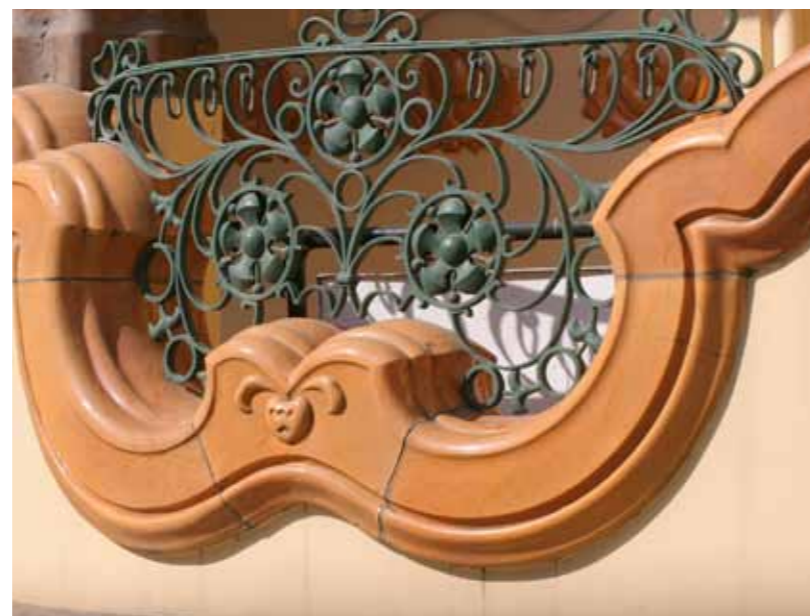
Detail of ceramic and iron railing on the main entrance porch Detall de barana de ceràmica i ferro al pòrtic de l'entrada principal
