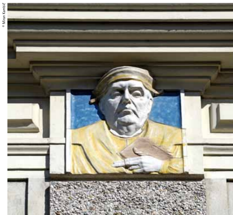
Detail of the Bamberg House façade Detall de la façana de la Casa Bamberg
