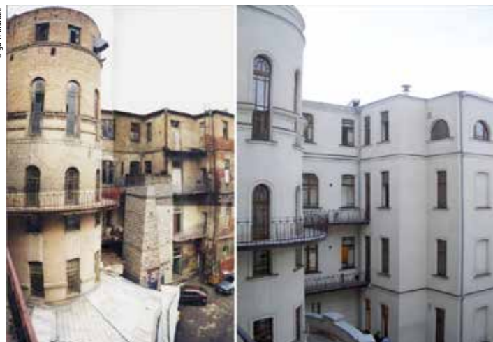
Interior courtyard, before and after restoration Pati interior, abans i després de la restauració
