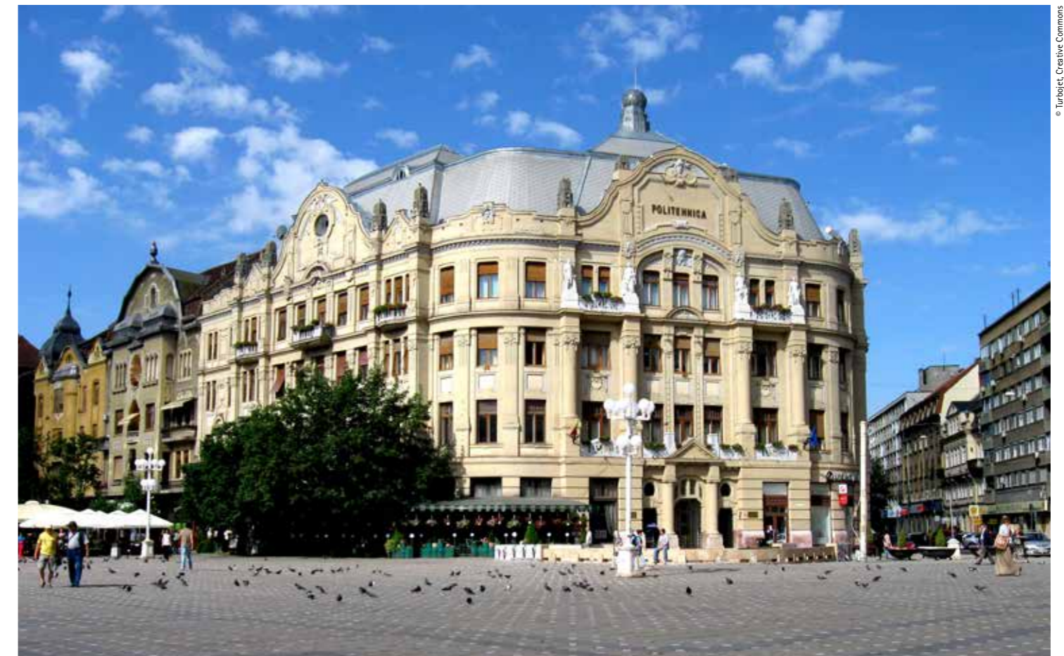
The Palatul Lloyd is an imposing feature on Victoriei Square, at one end of the Corso Boulevard El Palau Lloyd és una fita imponent de la plaça Victoriei, en un dels extrems del passeig Corso
