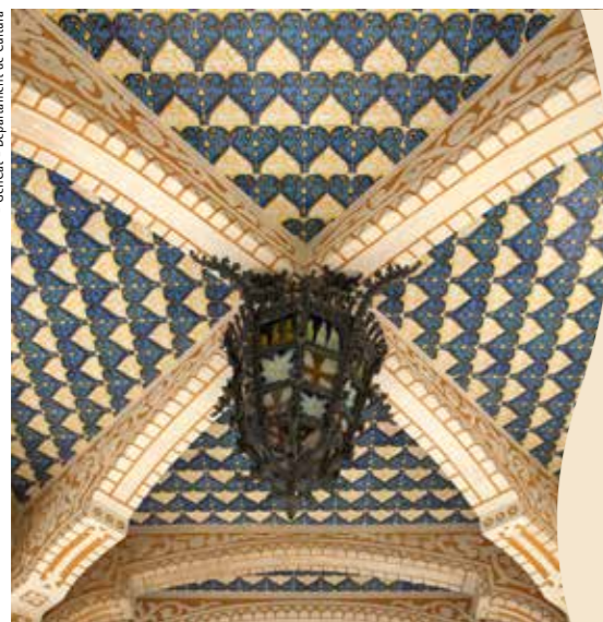
Detail of ceiling in Casa Gari in Argentina Detall del sostre a la Casa Gari d'Argentina
