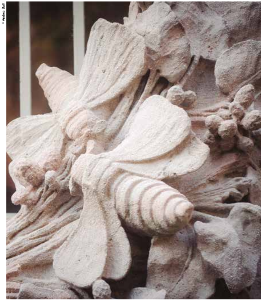
Sculptural detail on the façade representing a silk moth made of moulded cement Detall escultòric de la façana realitzat amb motlures de morter de ciment
