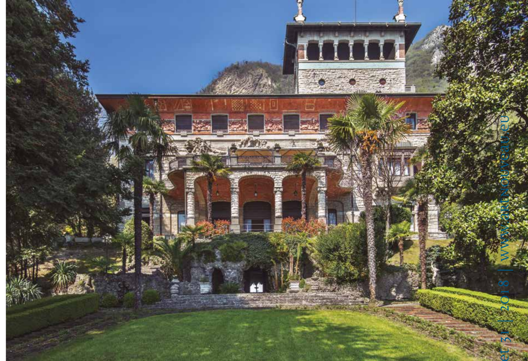
Façade of Villa Surre (1912). This building is a magnificent example of Sommaruga's ingenuity and fantasy Façana principal de la Vil·la Surre (1912). Aquest edifici és un magnífic exemple de la ingenuïtat i fantasia de Sommaruga
