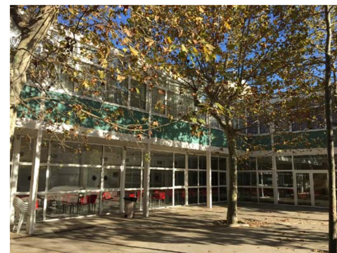
F12 Vista de les façanes de la plaça interior
