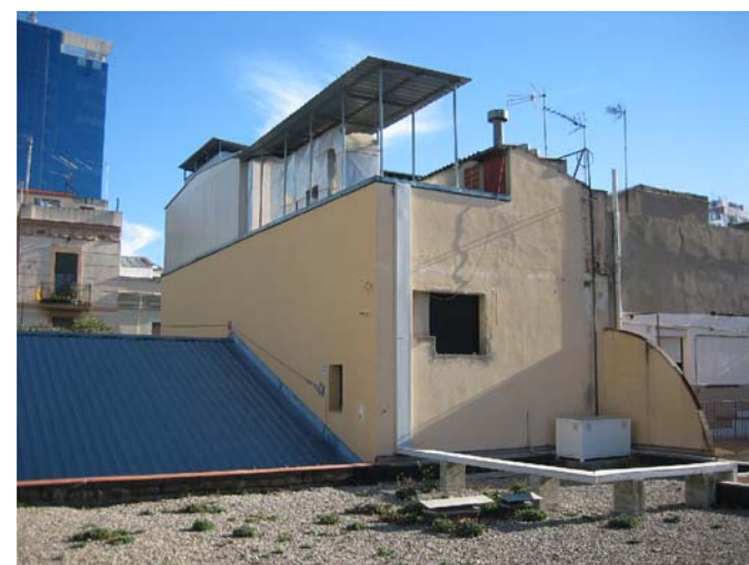
F11 Vista de la coberta
