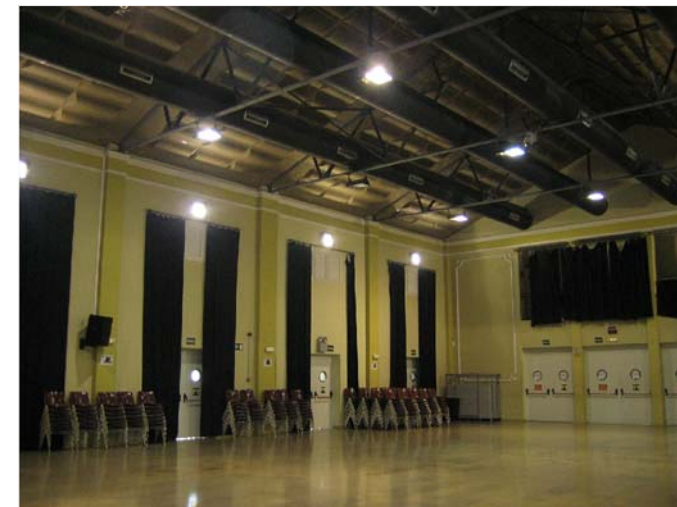
F04 Vista general del teatre
