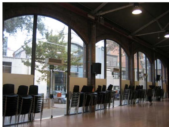
F05 Façana Nord , des de l'interior de l'auditori
