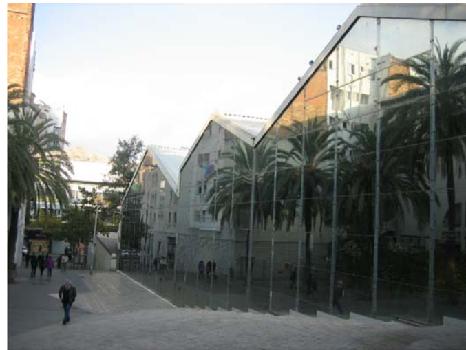
F02 Façana Oest
