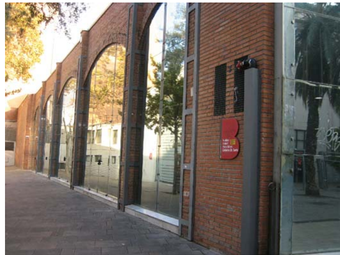
F01 Façana Nord
