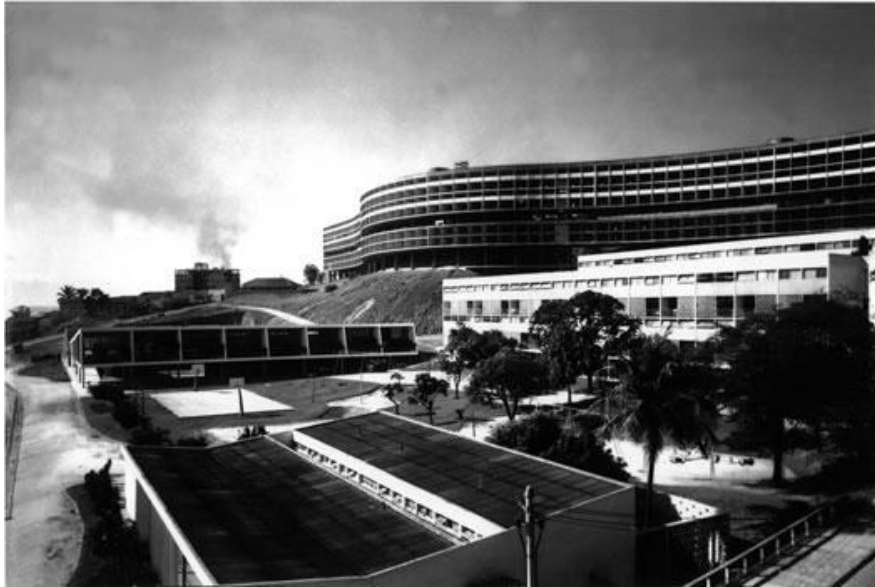
Pedregulho, conjunt d'edificis: habitatge i serveis. Imatge: EAD / PUCV
