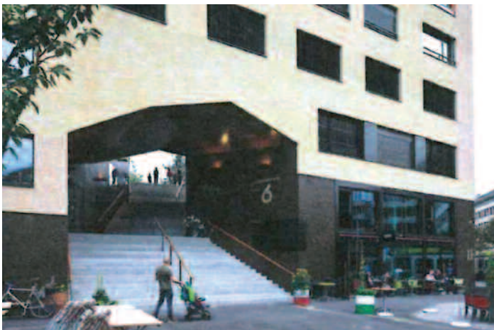
Imatge 4. Kalkbreite, Zürich. Cooperativa d'habitatges "Kalkbreite". Müller Sigrist Architekten AG
