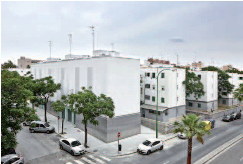
8. Renovación del Bloque XII de Camp Redó, Palma de Mallorca, a cargo de NIU Arquitectura.
