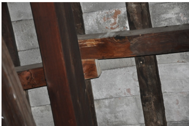
Minves de secció en zones properes al recolzament
