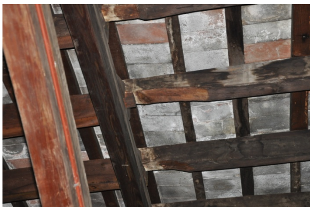
Minves de secció en zones properes al recolzament
