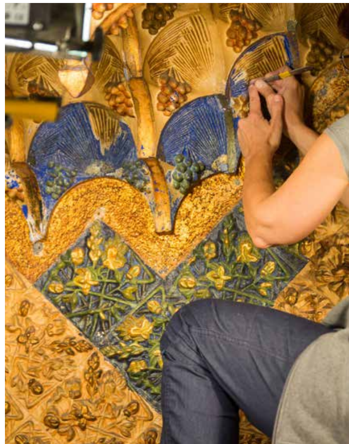
This page and opposite show the smoking room, one of the house's most singular spaces. Above, from left to right: the room before and during restoration of the papier-mâché. Next page: the smoking room after the works to recover the original polychromy on the walls and the plaster structure of muqarnas or mock-Islamic ornamented vaulting, which clads the ceiling Les imatges d'aquesta doble pàgina mostren el fumador, un dels elements més singulars de la casa. A dalt i d'esquerra a dreta: abans i durant la restauració del paper maixé. A la pàgina següent: després de la restauració es va recuperar la policromia original de les parets i de l'estructura de mocàrabs de guix que revesteix el sostre
