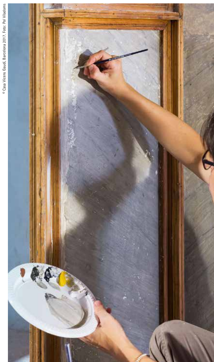
Restoration process of the stucco wainscoting on the first floor, which had been hidden beneath a layer of white paint Procés de restauració dels estucs al foc de la planta primera, que havien quedat amagats darrere una capa de pintura blanca
