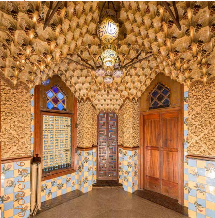
This page and opposite show the smoking room, one of the house's most singular spaces. Above, from left to right: the room before and during restoration of the papier-mâché. Next page: the smoking room after the works to recover the original polychromy on the walls and the plaster structure of muqarnas or mock-Islamic ornamented vaulting, which clads the ceiling Les imatges d'aquesta doble pàgina mostren el fumador, un dels elements més singulars de la casa. A dalt i d'esquerra a dreta: abans i durant la restauració del paper maixé. A la pàgina següent: després de la restauració es va recuperar la policromia original de les parets i de l'estructura de mocàrabs de guix que revesteix el sostre
