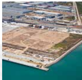
2 TERMINAL DE CONTENIDORS MOLL PRAT (FASE 2) ZONA NO CONCESSIONADA. ZONA DE MANIOBRA
