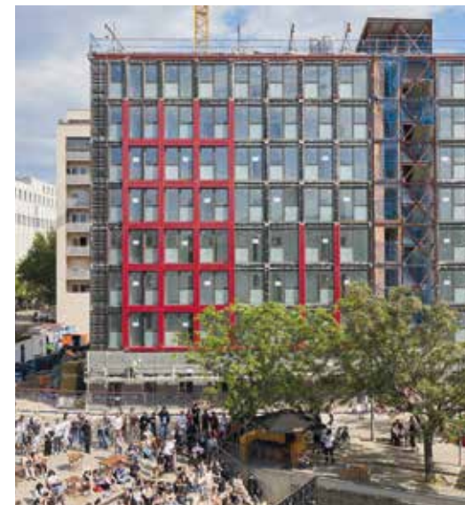
↑ Edifici APROP en construcció. Font: Ajuntament de Barcelona
