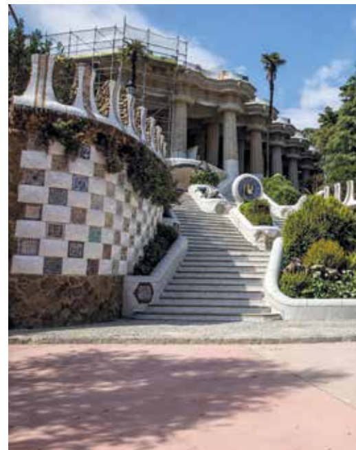
↑ Reparació sostre de la Sala Hipòstila. Font: Edu Bayer. Ajuntament de Barcelona
