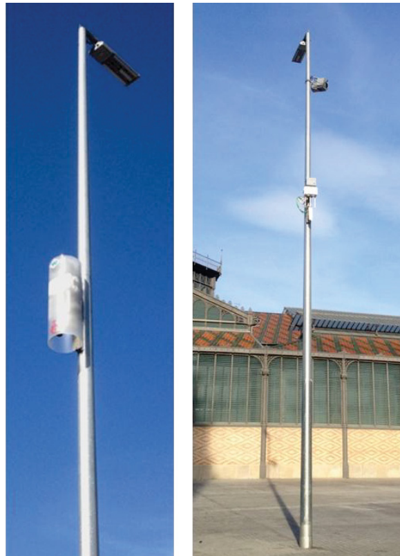
Figura 14 - Proposta de radom integrat al bàcul d'enllumenat
