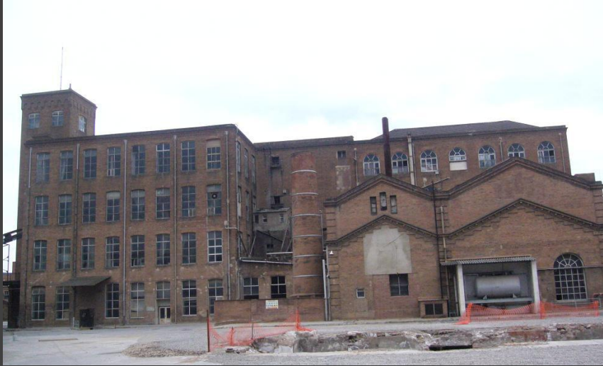
Fabra i Coats, Centre d'Interpretació i Sala de calderes
