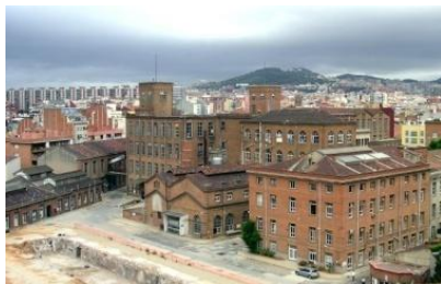
Fabra i Coats Treball, barri i ciutat Rehabilitació de les sales del sistema energètic + centre d'interpretació del treball, fase 1, amb participació teixit social
