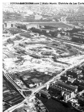
Camp Nou en construcció (1956)
