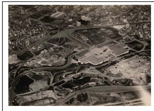
Inici de les obres de l'Exposició 1929
