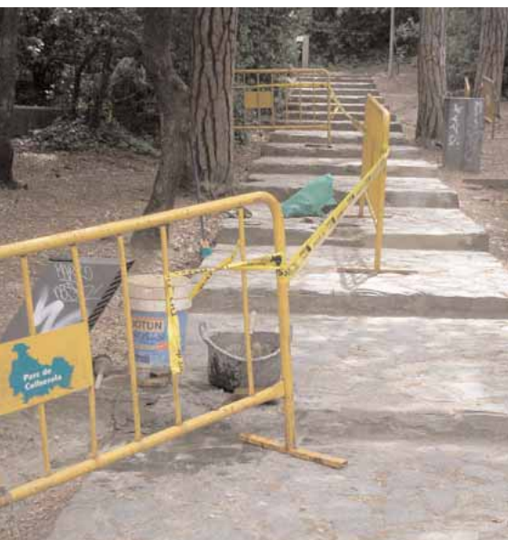
Arranament camí esglaonat del Centre d'Informació
