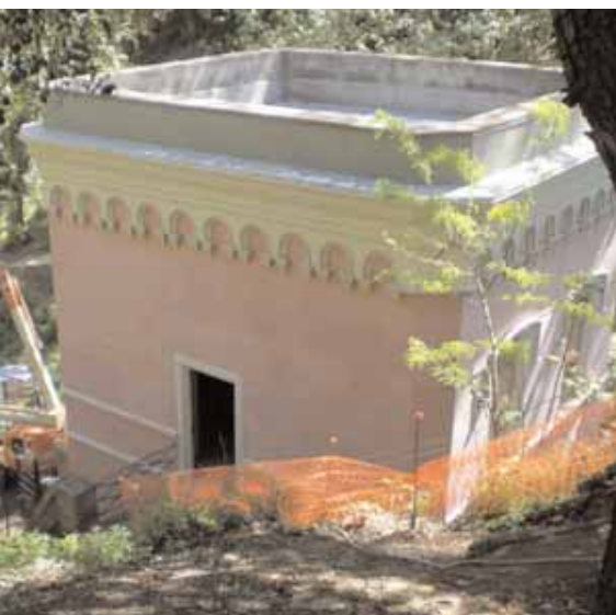
Casa del guarda del pantà de Vallvidrera
