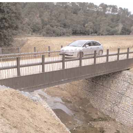
Obres del nou pont de can Borrell
