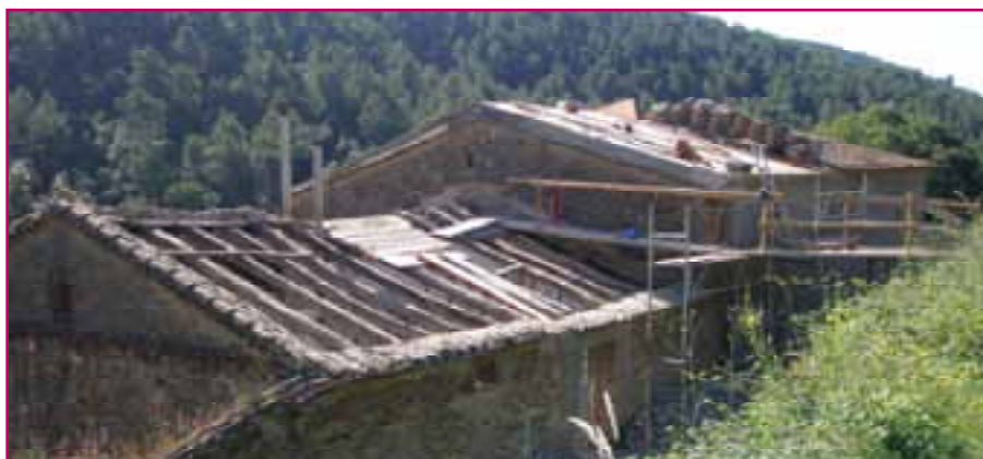
Reparació de la coberta de Can Ferriol
