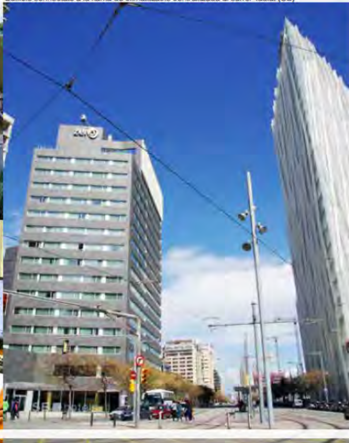
Edificis connectats a la xarxa de climatització centralitzada al carrer Taulat (CB)
