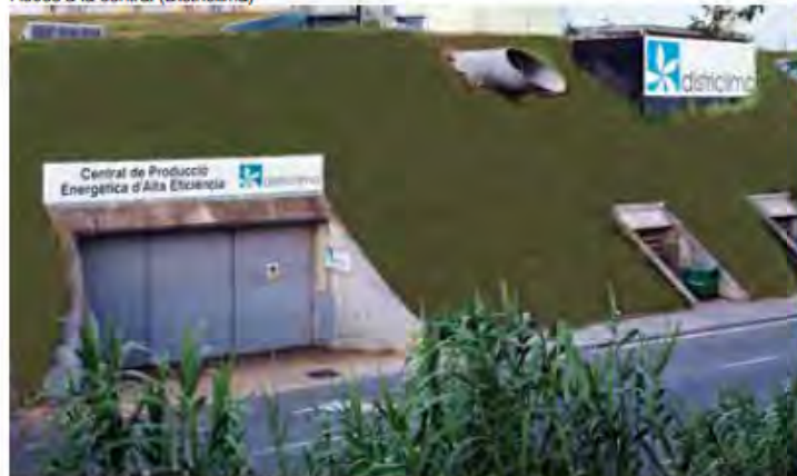
Accés a la central (Districlima)
