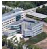
3 Edifici/Edificio Eureka I
