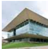
2 Edifici/Edificio Nexus II
