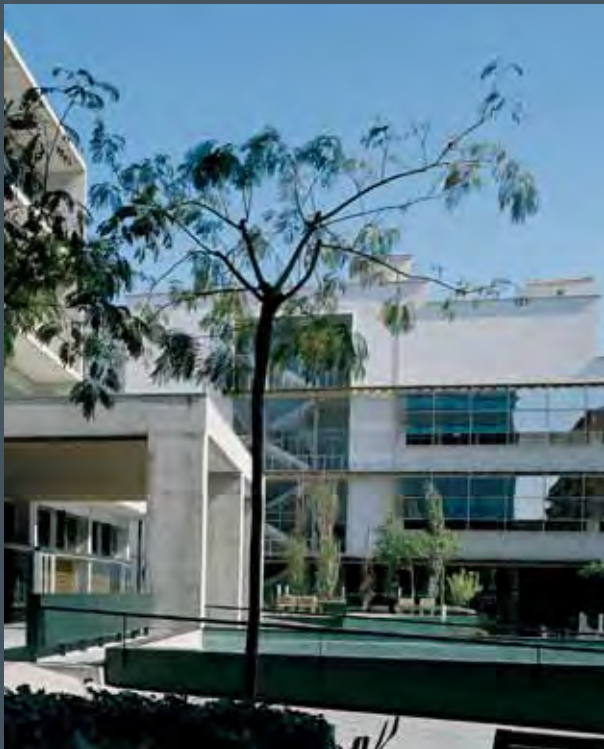
Vista de la façana de Barcelona Activa / Vista de la fachada de Barcelona Activa
