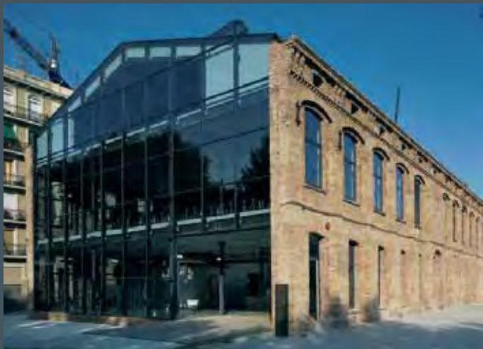
Can Jaumandreu, un dels equipaments especialitzats en ocupació / Can Jaumandreu, uno de los equipamientos especializados en empleo
