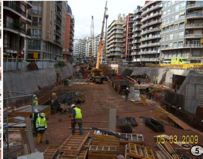
Col·locació de pantalles. Vista general de l'àmbit d'actuació
