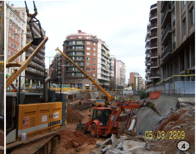
Iniciada la demolició de la vorera mar a l'alçada del C/Rios Rosas per poder construir les pantalles fins al C/Balmes
