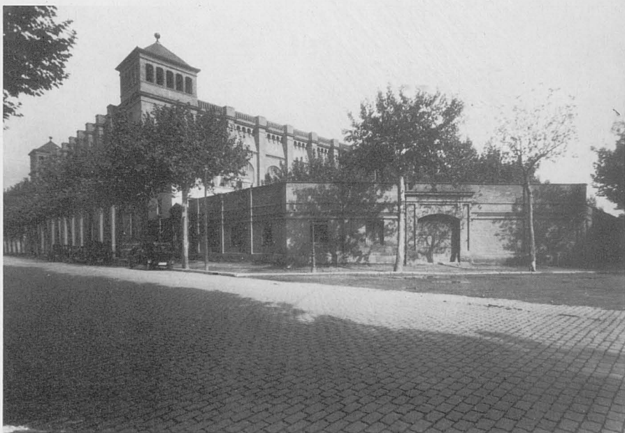
Aspecte del Laboratori Municipal abans de les darreres obres (Arxiu fotogràfic de l'Institut Municipal d'Història, Barcelona)
