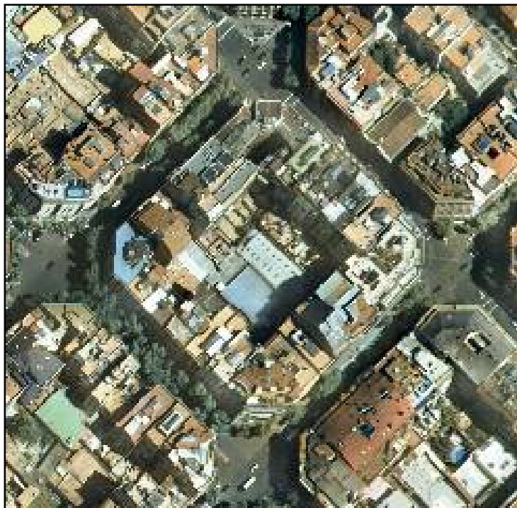
Imatge 3.1 – Vista aèria d'interiors d'illa de l'Eixample
