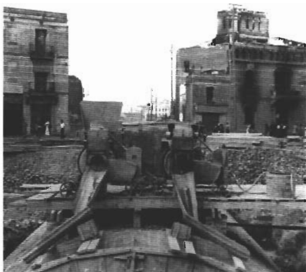
Construcció del túnel sota l'actual plaça de Sants, 1936. Pot veure-s'hi can Catà després de l'incendi
