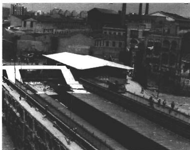
Andanes soterrades i rasa de la línia 5 del Metro, 1968
