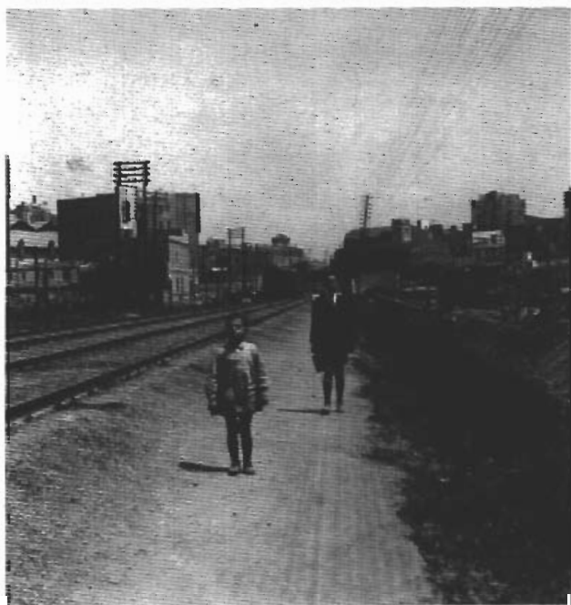
Voltants de les vies al carrer d' Antoni de Campmay durant les obres del metro transversal. 1925
