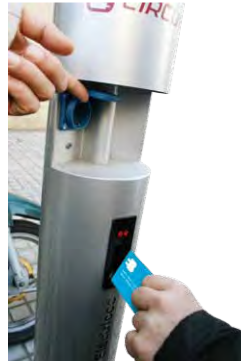
Punto de recarga para vehículos eléctricos
