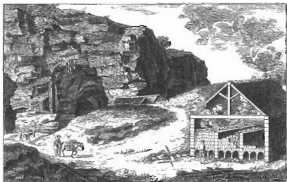
Pedrera i rajoleria.
