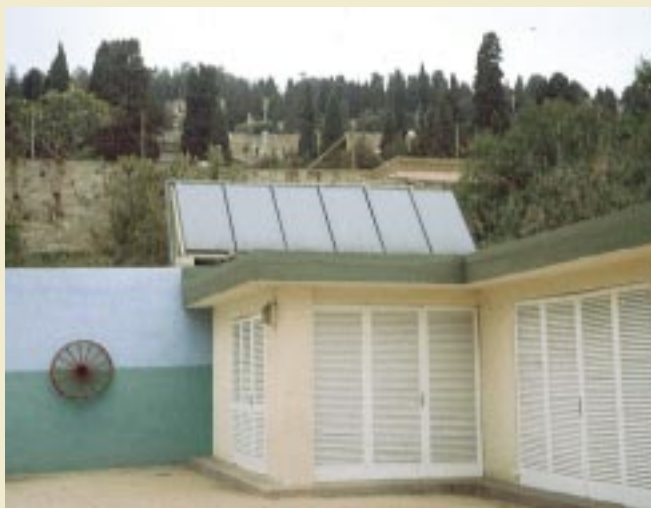
Ubicació dels captadors solars a l'Escola Bressol de Bellmunt
