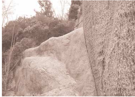
Geomalles als talussos de l'Històric
