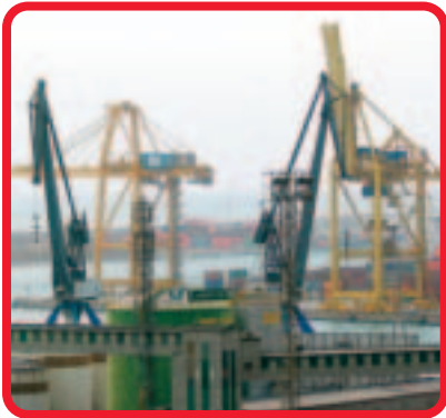
▲ Les enormes grues pòrtic són un dels elements característics del Port de Barcelona.
