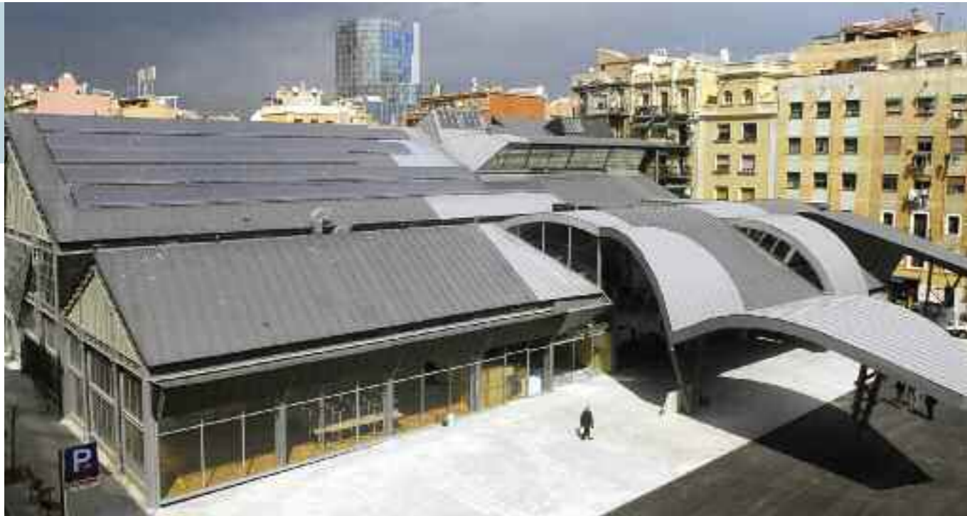
L'estructura de la que es partia es volia mantenir, com a memòria de l'edifici.
