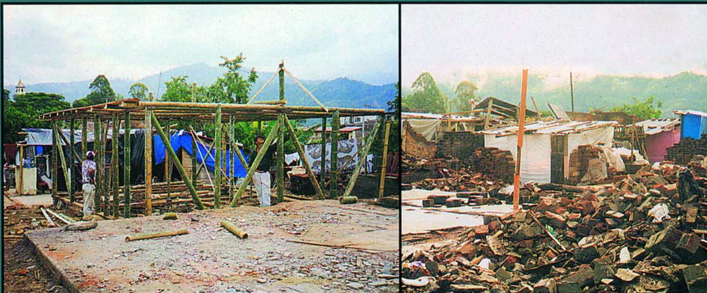
En les fotos de l'abans i el després, ja es comencen a veure els efectes dels treballs realitzats.
