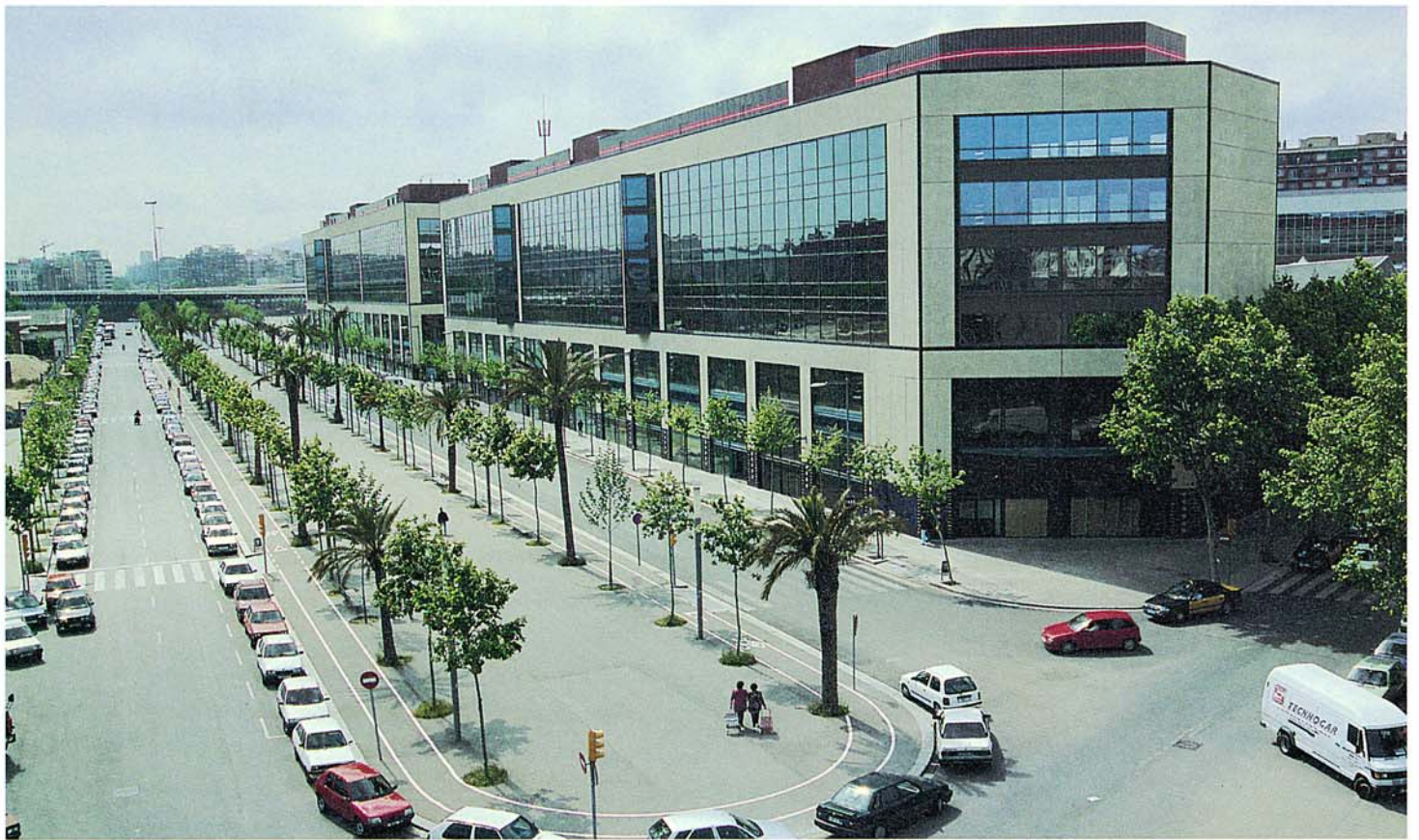
El tram de l'avinguda Diagonal més proper a la plaça de les Glòries ja està urbanitzat.
