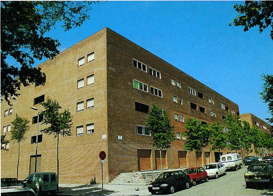
Un dels nous blocs de pisos que s'han construït al barri d'Eduard Aunós.
