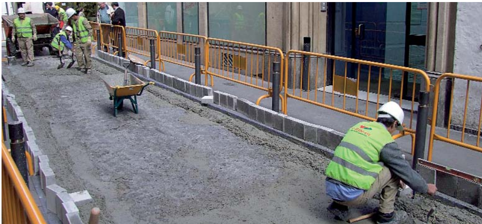
Obres al carrer Avinyó
