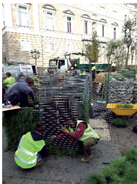
Treballs d'instal·lació del pessebre a la plaça de Sant Jaume
