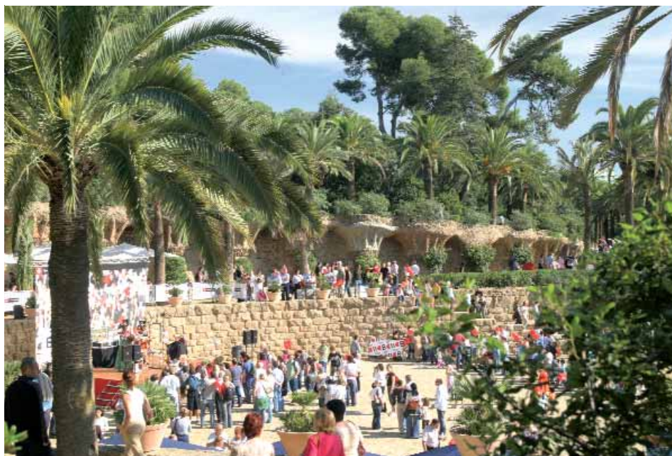
Plaça de la Natura. Aquesta és una de les zones del Park Güell on s'han fet treballs de rehabilitació integral
