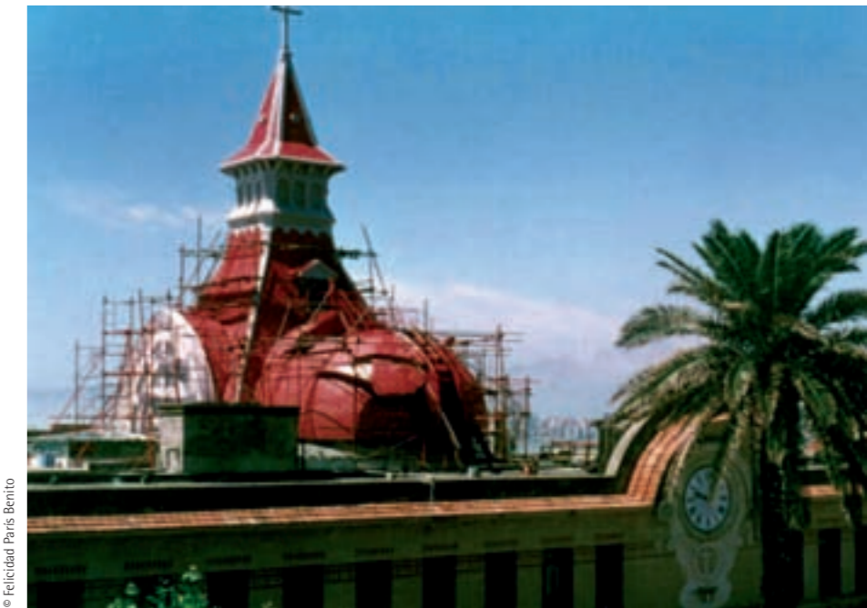
Restoration of the tower in 1995. Restauració de la torre en el 1995.
