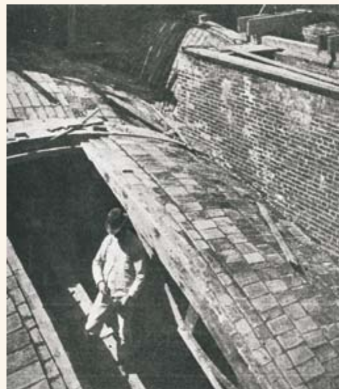
Boston Public Library in 1908, during construction of tile dome and ribs Biblioteca Pública de Boston el 1908, durant la construcció de la cúpula i els nervis
