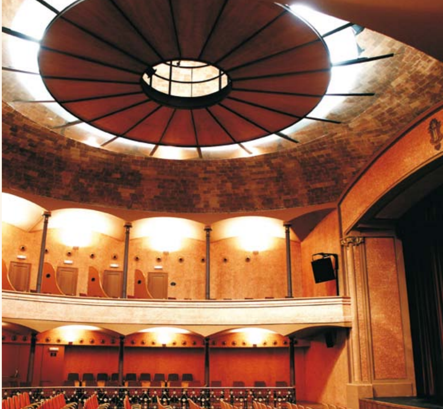
Dome of the Vilassarenc Centre theatre after its 2002 restoration / Cúpula del teatre del Centre Vilassarenc després de la restauració de
