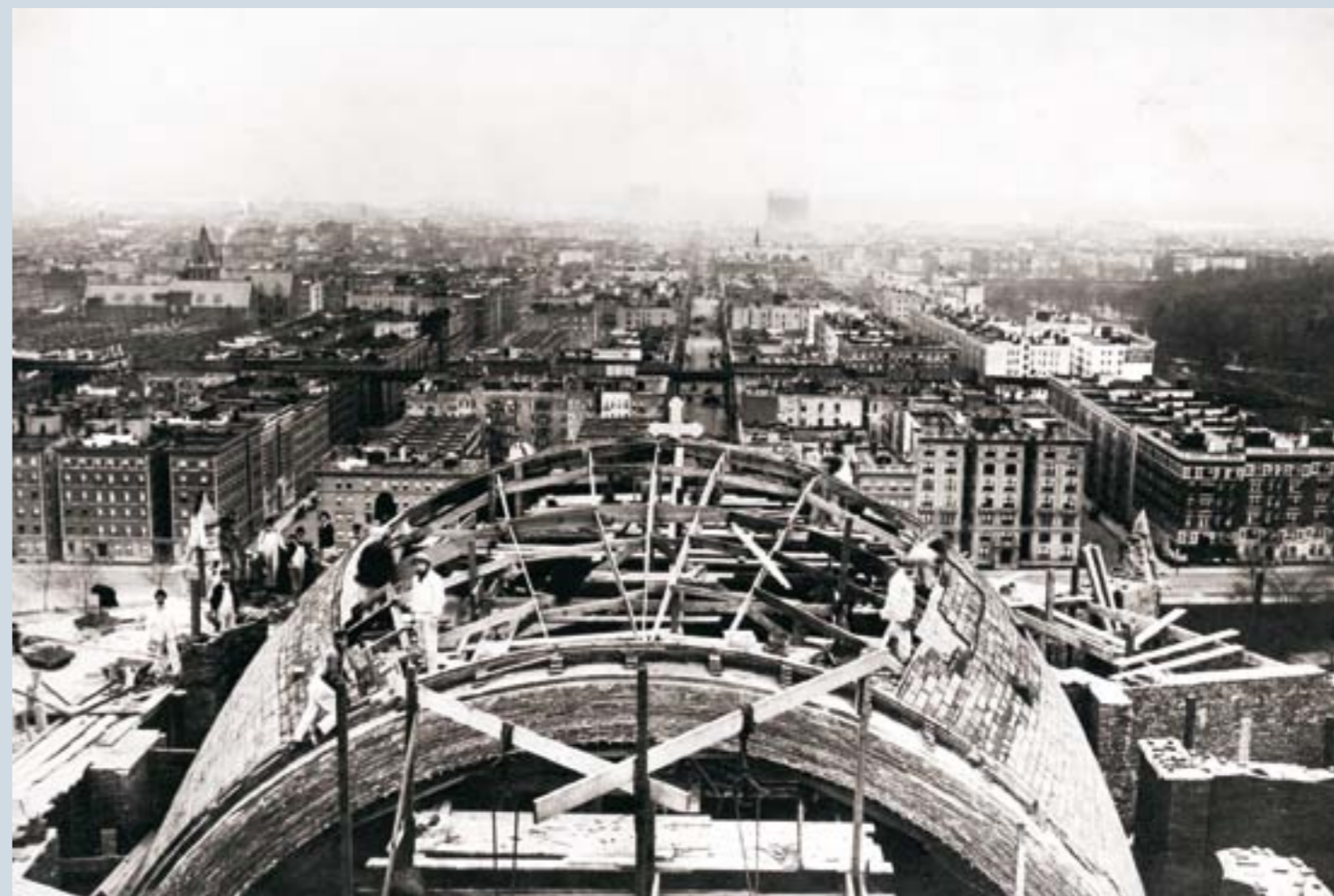
Cathedral of St. John the Divine, 1908. View from the top with workers Catedral de St. John the Divine, 1908. Vista des de dalt amb treballadors
