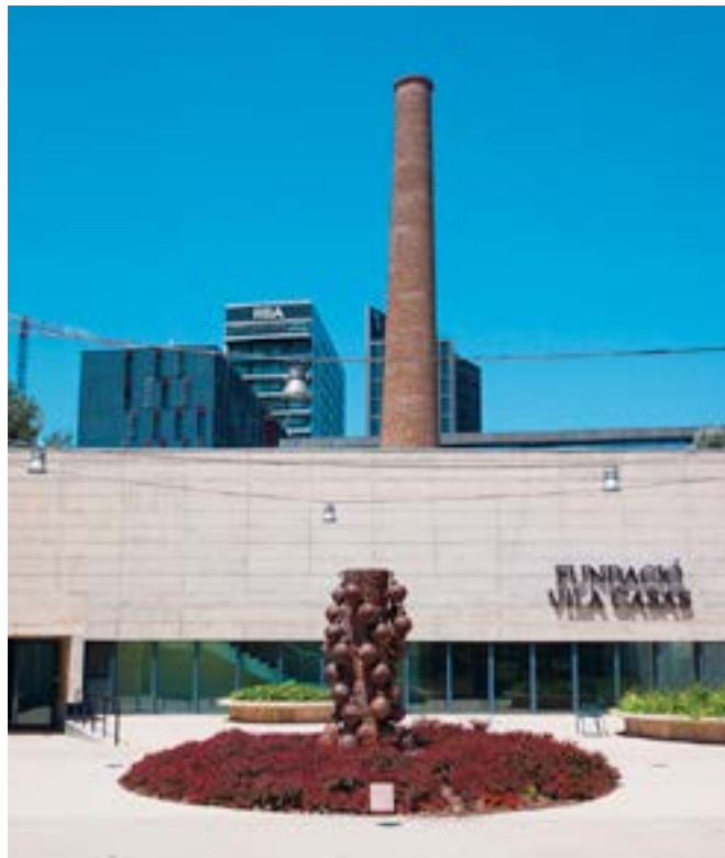
Rastros del pasado industrial conviven con ejemplos de arquitectura moderna
